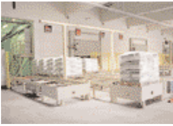
Verpackungsmaschinen im Werk Bernburg
