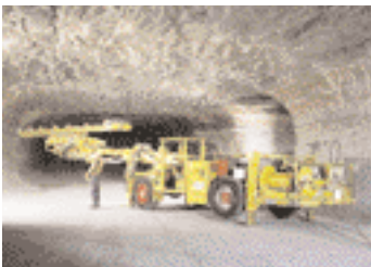
Sprenglochbohrwagen im Grubenbetrieb des Werkes Zielitz
